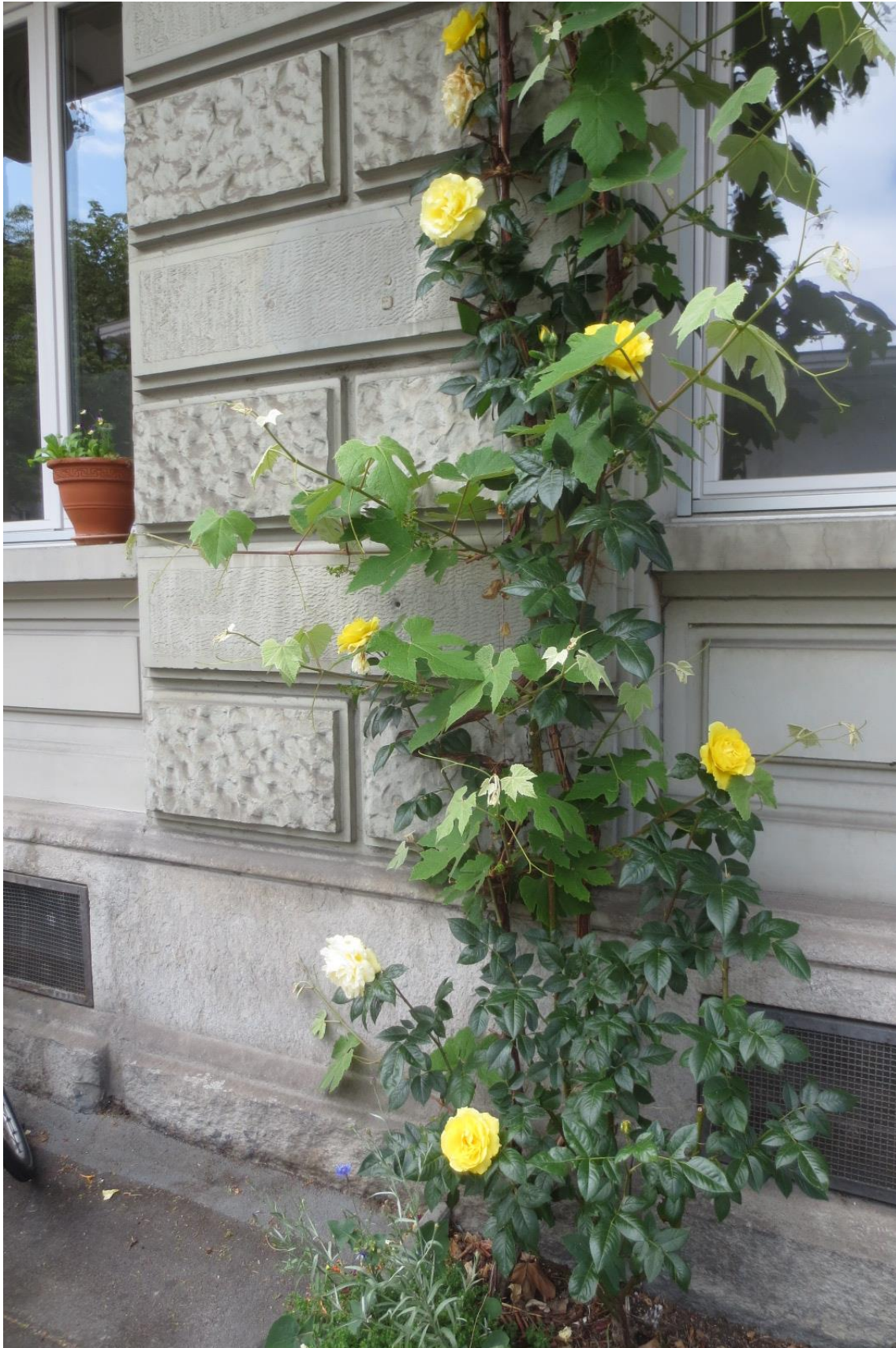
Fassadenbegrünungen lassen sich selbst mit wenig offenem Boden realisieren.
