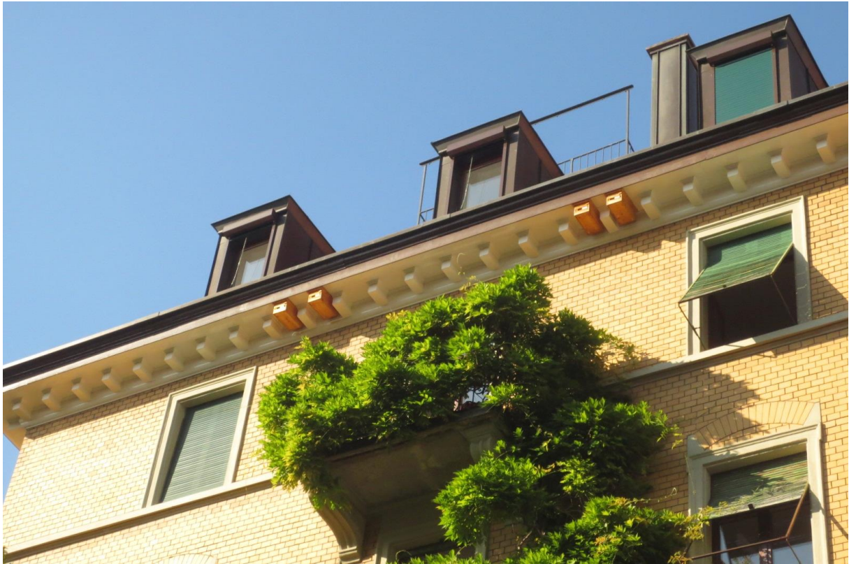
Mauerseglerkästen an der Unterseite des Dachvorsprungs.
