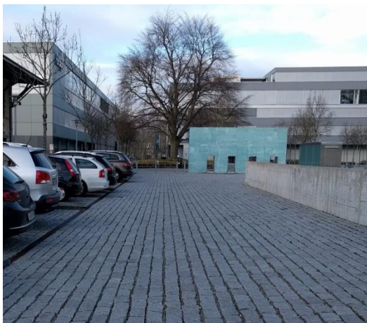
Kopfsteinpflasterung mit Sickerfugen: hier kann Regenwasser vor Ort versickern.
